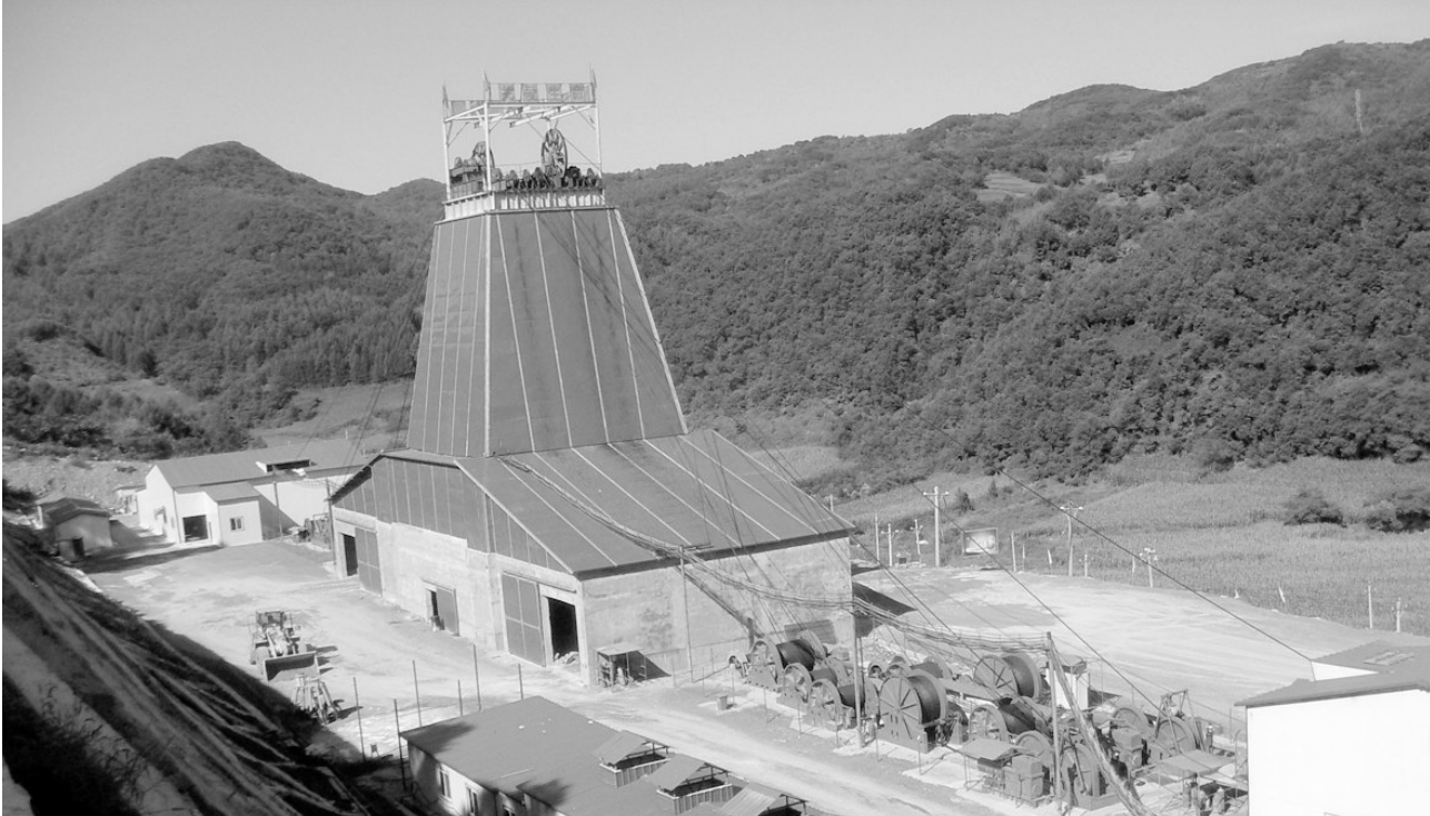
矿建工程(省外) 辽宁本溪龙新矿业思山岭铁矿工程。
