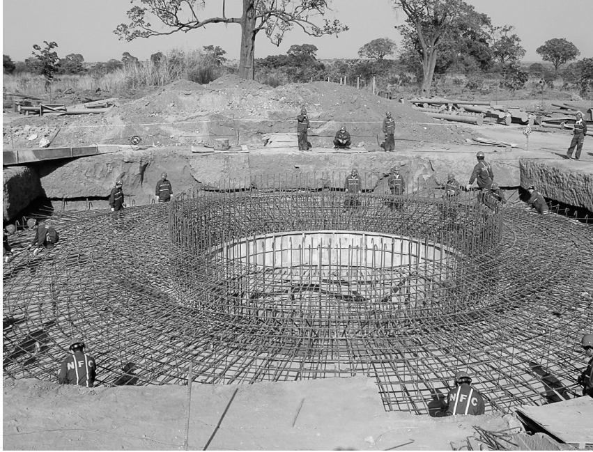
赞比亚工程VS3E井井颈段钢筋绑扎施工
