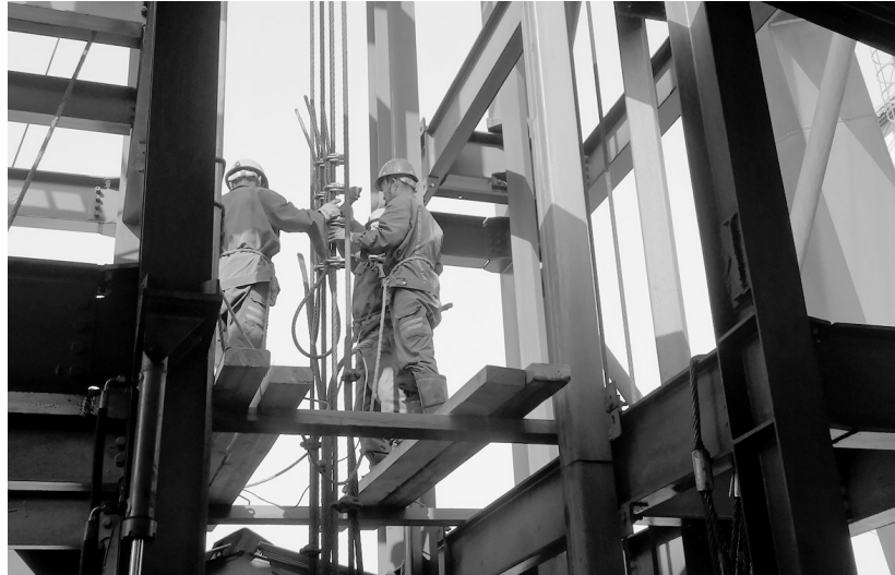
10月21日,经过4天的连续奋战,天马山矿业公司完成天马副井4根直径为28毫米提升首绳更换任务,为矿山安全生产奠定了坚实基础。朱艳 刘红霞 摄
