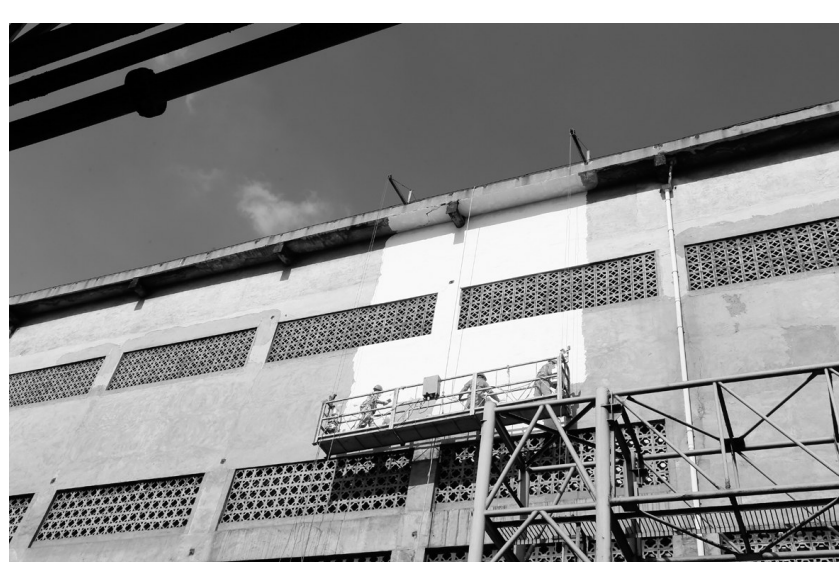
金隆铜业公司对原料库墙面进行美化修缮。该公司原料库已使用了二十多年，部分墙面出现老化现象。为确保生产安全，美化厂容厂貌，该公司对库房墙面进行重新粉刷，使之焕然一新。 章庆 摄
