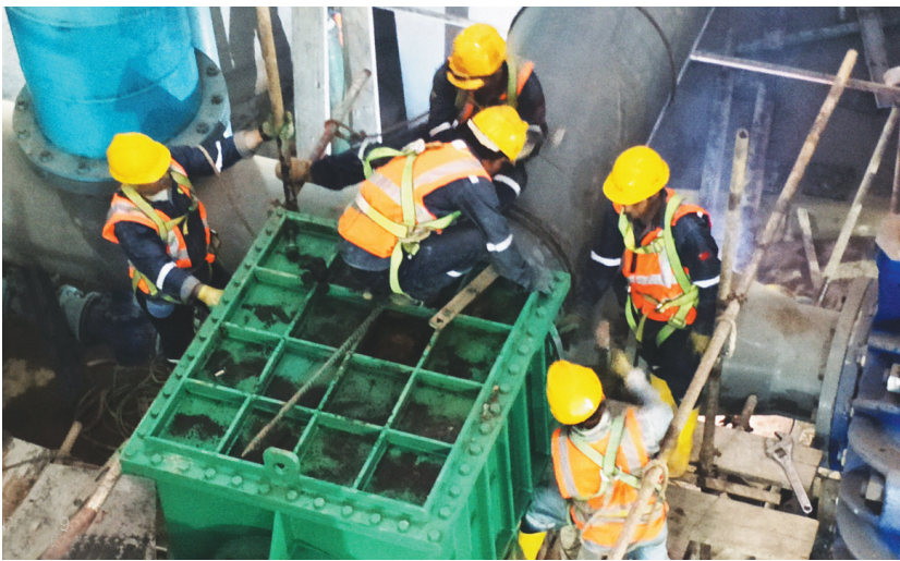
铜冠建安厄瓜多尔分公司职工正在深井泵房内安装DN800钢衬管道2号线。该分公司在承建的米拉多铜矿直径18米深井泵房项目施工中,克服深井设备运输、吊装不便等诸多困难,较好地保证了施工安全和进度。
