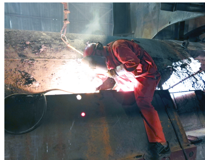
从9月1日开始,工程技术分公司专业项目部检修人员的身影在金隆铜业公司2号阳极炉检修现场随处可见。筑炉班顶着炉内的高温检查需要更换的镁砖进行局部补砌施工,于8日17时比计划提前8个小时完成检修任务,经业主一次性验收合格。图为这个项目部机械班员工现场配合筑炉班仔细紧固螺丝、上好接头、焊牢每个焊口操作场景。
