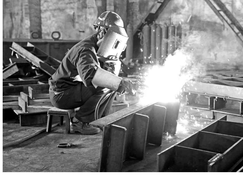
铜冠机械公司矿冶设备制造分厂职工日前穿戴整齐开展焊接作业(如图)。矿冶设备制造分厂在搬迁过程中针对厂房老化现象,为确保安全生产,一方面积极在厂房内布设安全防护网,一方面严格要求职工作业时穿戴好劳保用品。
