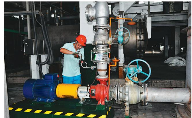
今年以来,铜冠铜箔公司铜箔三四工场全面推进TPM(全员生产维修)管理,通过抓细节、抓全员、抓精准,调动每一名职工对生产现场、设备和工作效率的改善热情,提高大家的节约意识,减少设备故障,以达到降低成本增加效益的目的。图为工场溶铜工段员工正在给硅藻土搅拌机加润滑油。
