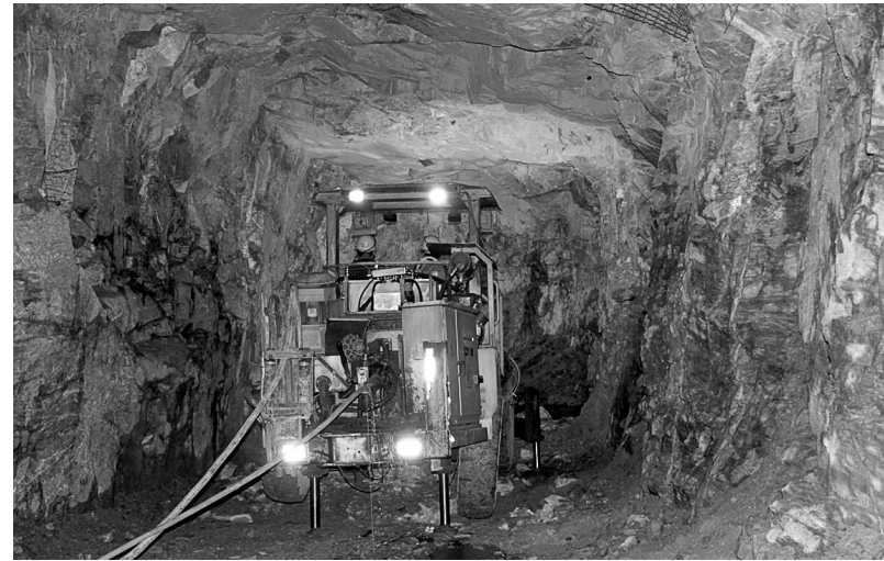
冬瓜山铜矿目前已全面投入深部开采 掘进施工任务重 工程量大 矿山充分发挥大型无轨设备高效率的优势 积极培养一支生产中能挑大梁 技术上有一手的掘进先行队伍 为采矿衔接打下坚实的基础。今年1至7月份 矿山掘进量完成8.6万立方米 超计划25%。图为该矿掘进凿岩台车正在井下作业场景。汤菁 摄
