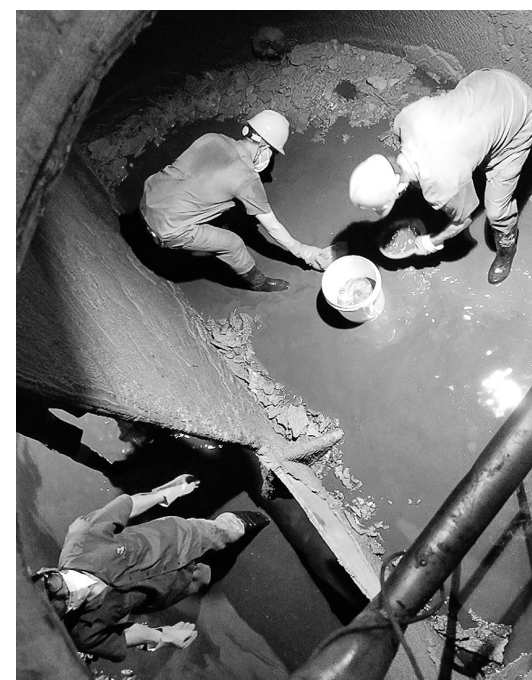
近日,张家港铜业公司组织人员对罐体进行清理。该公司电解5期低位槽罐体结垢,连通阀门连接腐蚀、堵塞严重,员工们克服天气炎热、作业空间狭小,连续作战清理罐体结垢近500袋,为早日恢复生产赢得了宝贵时间。
