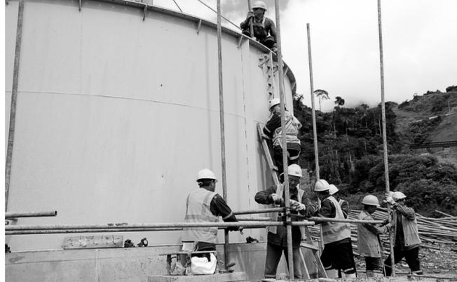
铜冠建安厄瓜多尔分公司职工正在进行中和反应槽施工。由铜冠建安厄瓜多尔分公司承建的米拉多铜矿酸性水处理站工程，经过精心组织施工，目前工程已进入关键节点阶段，分公司有望如期完成该工程施工任务。
