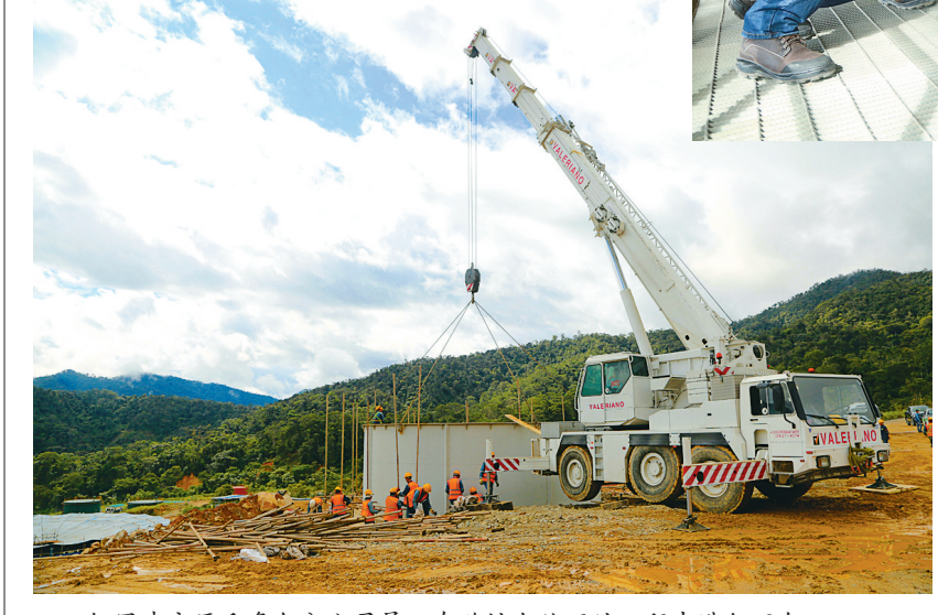
铜冠建安厄瓜多尔分公司员工在酸性水处理站工程中进行石灰吊槽安装作业。
