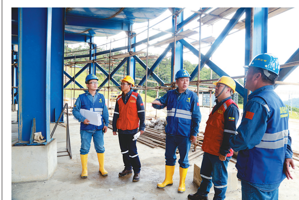
鑫铜监理厄瓜多尔分公司员工在检查浓缩机安装施工。
