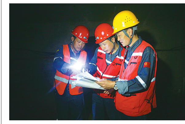
铜冠矿建公司米拉多项目员工在废旧皮带隧道施工技术现场交底。
