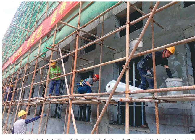
日前,铜陵建安装饰公司承接的有色集团公司展示馆及档案楼改造施工现场,工人们正在进行外墙的抹灰施工作业。他们正抢抓工期,赶进度,力争8月中旬按时交工。
