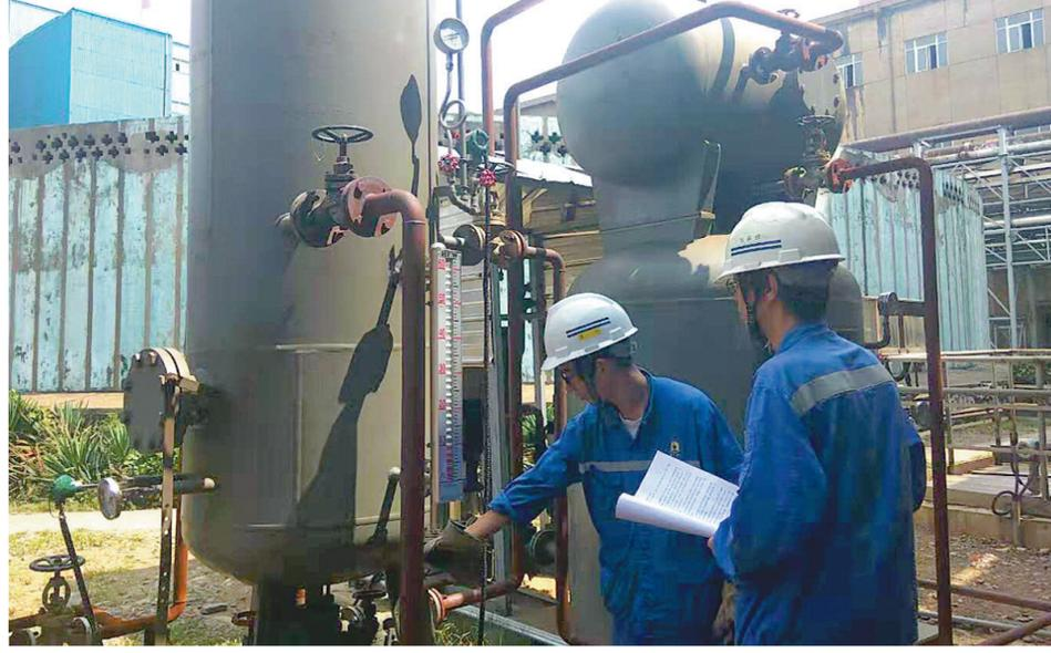
近日,金隆铜业公司动力中心冷凝水回收装置投入使用。这项装置的投用,将原本外排的冷凝水和热源回收再利用,降低了生产成本,减少了汽轮机疏水排放产生的白色污染和噪音。据测算,这项装置每年综合成本节约50万元,效益可观。
