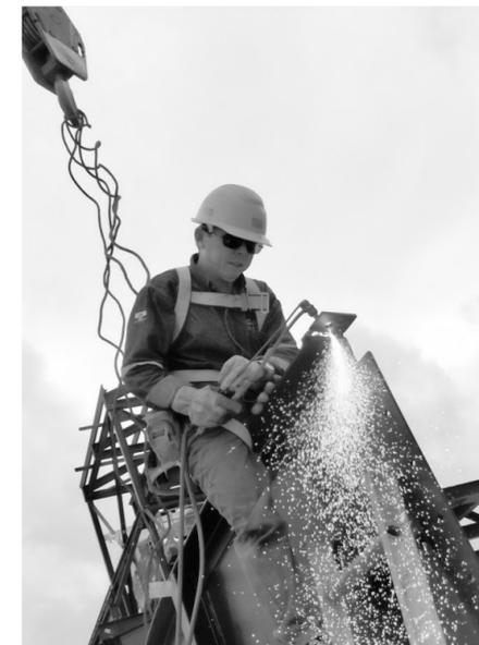
6月19日,铜冠建安厄瓜多尔分公司安装钳工赵志峰在吊装作业。由铜冠建安厄瓜多尔分公司承建的厄瓜多尔米拉多铜矿粗选浓缩池疏流、进料系统已经全面展开吊装,其主要吊装对象为疏流吊架和疏流槽,进料与疏流衔接导流段,以及进料管系统等三大部分。此次吊装总部件重量近百吨,作业高度在4到20米,针对大量的空中吊装作业,分公司积极做好了合理的施工方案。陈致生 王红平 摄
