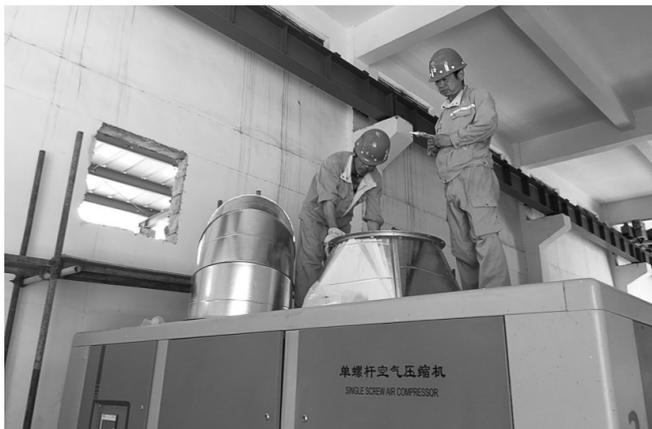
近日,铜冠(庐江)矿业公司动力运转中心组织人员对空压机散热系统进行改造。技改后可有效改善空压机散热系统,提高设备运行稳定性和降低能耗,为高温天气保证空压机的正常运行创造条件。 夏富青 包民 摄
