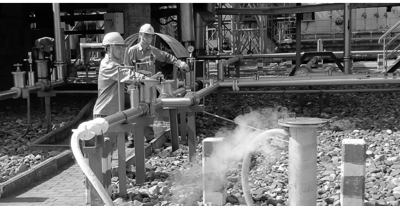
日前,金冠铜业分公司动力车间在制氧站液体储罐区域开展“低温液体充装泄漏”模拟演练,以进一步强化和提升作业人员安全生产意识和突发状况应急处置能力。图为现场操作人员“紧急”关闭手动液氨排放阀。 王 丹 摄
