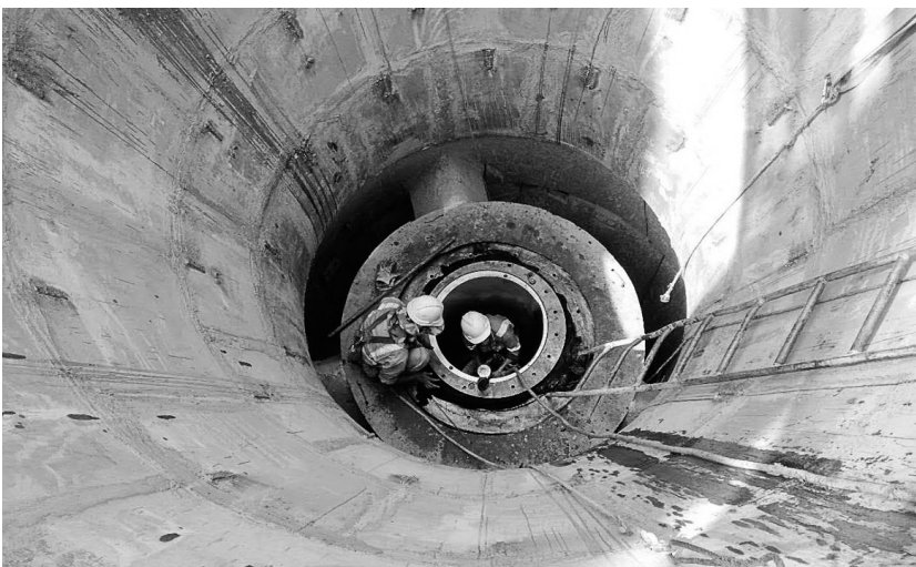
5月8日起,缅甸莱比塘项目对2号旋回破碎机进行大修。作业现场,维修工作人员克服高温、大吨位起吊、作业工艺复杂等困难,于17日上午,圆满完成2号旋回破碎机大修,确保了下一阶段生产工作有序进行。 黄志皓 摄
