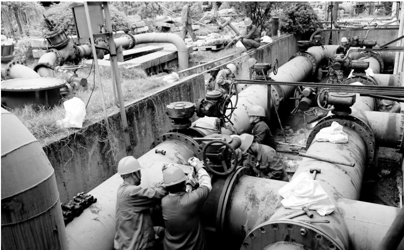
闪速炉是金隆铜业公司铜冶炼的核心设备,保持闪速炉循环水冷却系统正常运转,直接关系到炉体安全,是企业持续生产的重要条件。为保持生产安全有序,该公司定期对闪速炉循环水系统进行检修维护,防止因意外情况发生引发炉体事故。 图为设备维护人员正在对供水阀门进行更换。 章庆 摄
