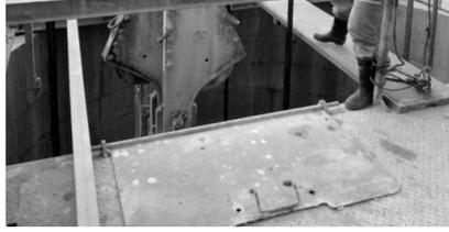
金陵铜业公司相关人员正在更换纯水处理、阳离子交换器内的树脂(如图)。该公司去年纯水生成量近70万吨,产生的经济效益和社会效益明显。为确保纯水质量和生产工艺稳定,该公司严控技术流程,定期更换树脂,避免水质不稳给冶炼生产造成不利影响。
