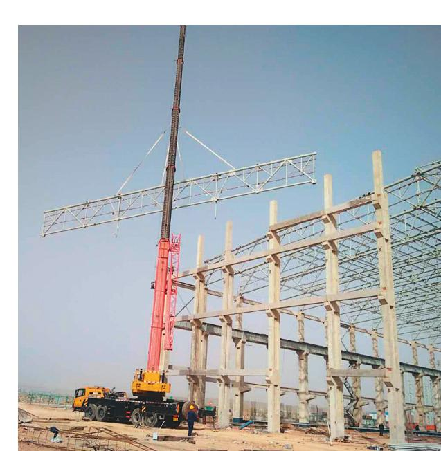
日前,随着最后一榀钢屋架吊装就位(如图),铜冠建安钢构公司顺利完成赤峰金剑电解工序钢结构主体吊装任务,为后续工程维护结构的安装提供了保障。
