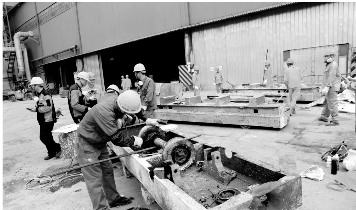
日前,在金隆铜业公司设备大修现场,身穿不同工作服的各公司职工正在有条不紊地忙碌着(如图)。该公司严把大修期间安全生产关,要求所有参与大修人员必须接受安全教育,必须正确穿戴劳动防护用品,否则一律按“三违”论处,确保了设备大修工作安全正常向前推进。章庆 摄
