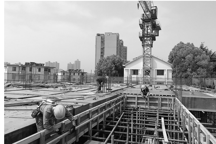
4月17日,铜冠建安装饰公司承建的有色展示馆工程,施工人员进行一层模板支护作业。前期,因为设计变更等因素的影响,致使该工程工期有些滞后,铜冠建安装饰公司针对这一变化,通过重新编排调整施工计划,组织施工力量保安全、抢进度,争取高效优质地完成项目施工,为集团公司成立70周年献上一份厚礼。王红平 汪锡铜 摄
