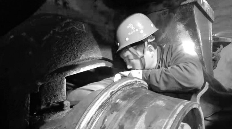
3月下旬,铜山铜矿分公司对矿山设备开展安全大检查,要求对井下、地面各单位使用设备进行安全自检,围绕生产过程对每台设备进行全面、系统、深入的检查,对发现的问题及时整改维护,念紧设备“安全经”。图为维修工正在拆卸铲运机补油泵更换密封圈。 余 飞 代光明 摄
