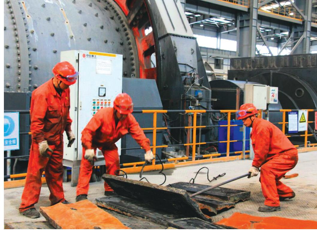
4月2日下午,工程技术分公司承接的铜冠(庐江)矿业有限公司选矿车间球磨机衬板更换项目按工期要求顺利完工并通过验收。此次项目按业主方要求分两期施工,共拆换衬板360块,拆除和更换的衬板重量约300吨。图为公司专业项目部员工正在现场作业。
