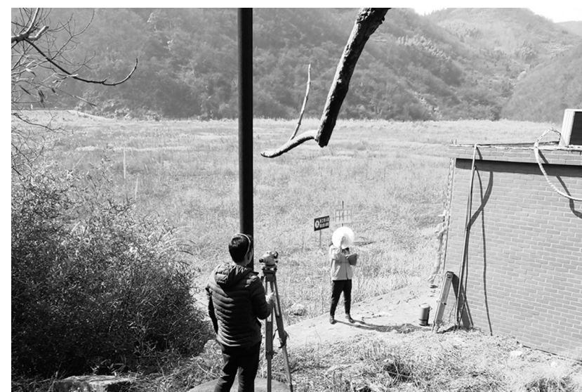
为切实做好凤凰山矿业公司尾矿库安全监管管理工作,日前,该公司生产部完成了相思谷尾矿库及林冲尾矿库的坝体水平、沉降位移的人工测量作业,并将检测结果总结后按规定上报,确保观测数据及时、准确、高效。 牛海涛 摄
