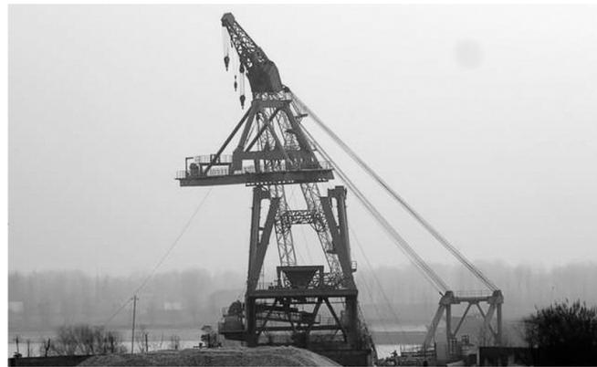
近日,在一台大型起吊机的配合下,铜冠物流金固港埠分公司每小时800吨桥式抓斗卸船机的桥梁顺利安装到位(如图),这标志着卸船机的主体工程已全部完成,即将进入联调联试阶段。此举为更好更早期服务于铜陵有色集团公司增添了新的力量。
