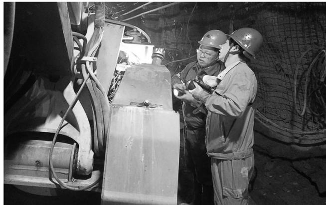
汛期即将来临,铜冠(庐江)矿业公司动力运转中心提前谋划,一方面加强井下主排水设备设施的巡查、点检、维护、保养,另一方面组织人员使用时间长、能效低的1号主排水泵进行更换,进行返厂大修,并将此作为汛期备用泵,以确保安全度汛。
