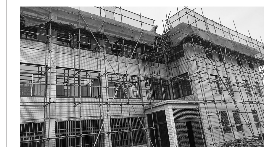
铜冠建安装饰公司职工日前正在楼顶进行防水处理(如图)。该公司承建的集团公司武保部水上救援大队办公楼改造工程是原金昌冶炼厂招待所。该公司抓住当下晴好天气,组织抓紧施工,抢回因前期雨季影响的工期,力争月底前完工。
