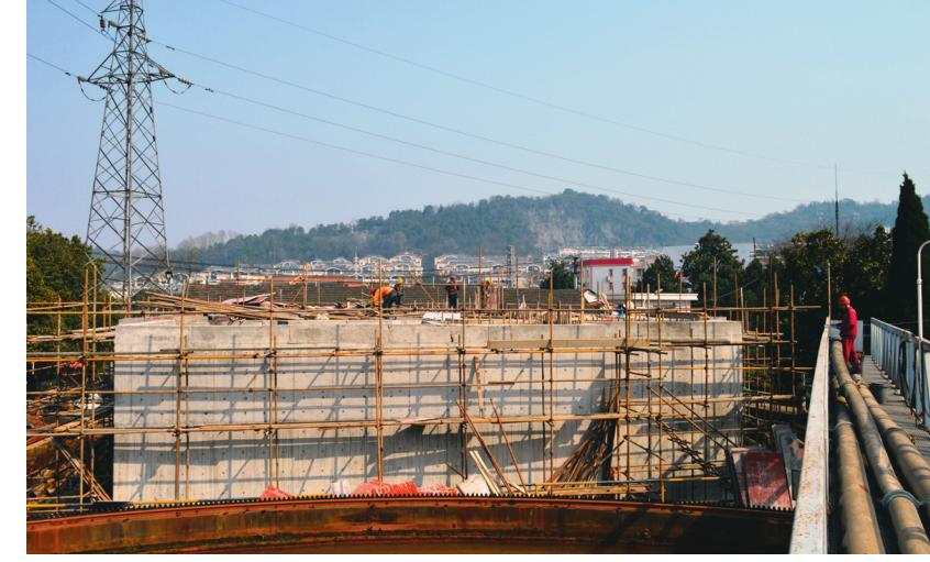
日前,天马山矿业公司东村净化站改扩建工程建设如火如荼,这个项目于3月8日完成高密度沉淀池主体设施建设。目前,已进入设备安装阶段。改造后这个系统日处理水能力将由现在的9000立方米增至33000立方米。 朱艳 王刚强 摄
