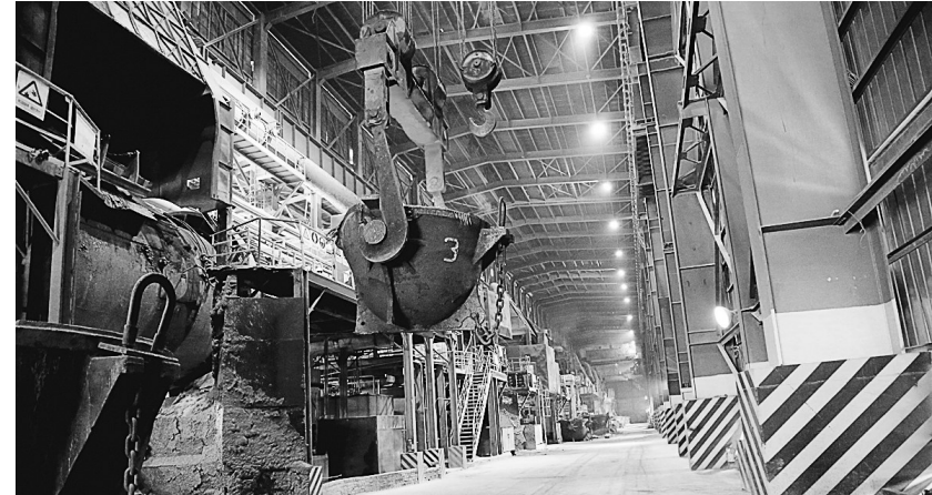
针对现场施工队伍众多，施工频繁的实际现状，金隆铜业公司精炼车间强化生产现场安全管理，规定主行车在吊运铜熔液期间，任何在现场的施工人员都必须采取规避措施，避免安全事故发生。图为铜溶液调运时安全规范的生产现场。
