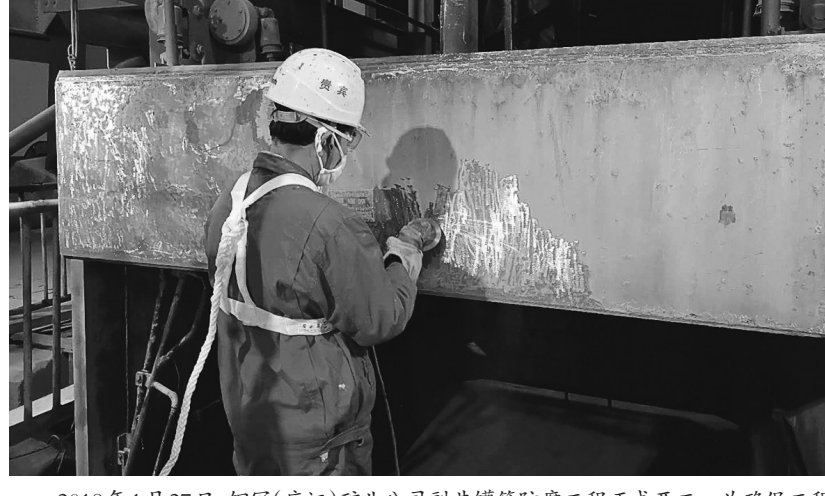
2018年1月27日,铜冠(庐江)矿业公司副井罐笼防腐工程正式开工。为确保工程顺利,避开春节前井下设备检修、罐笼防腐工作时间,该公司周密筹划,自1月27日起每日16时至23时进行作业施工,工程于1月31日完工。
