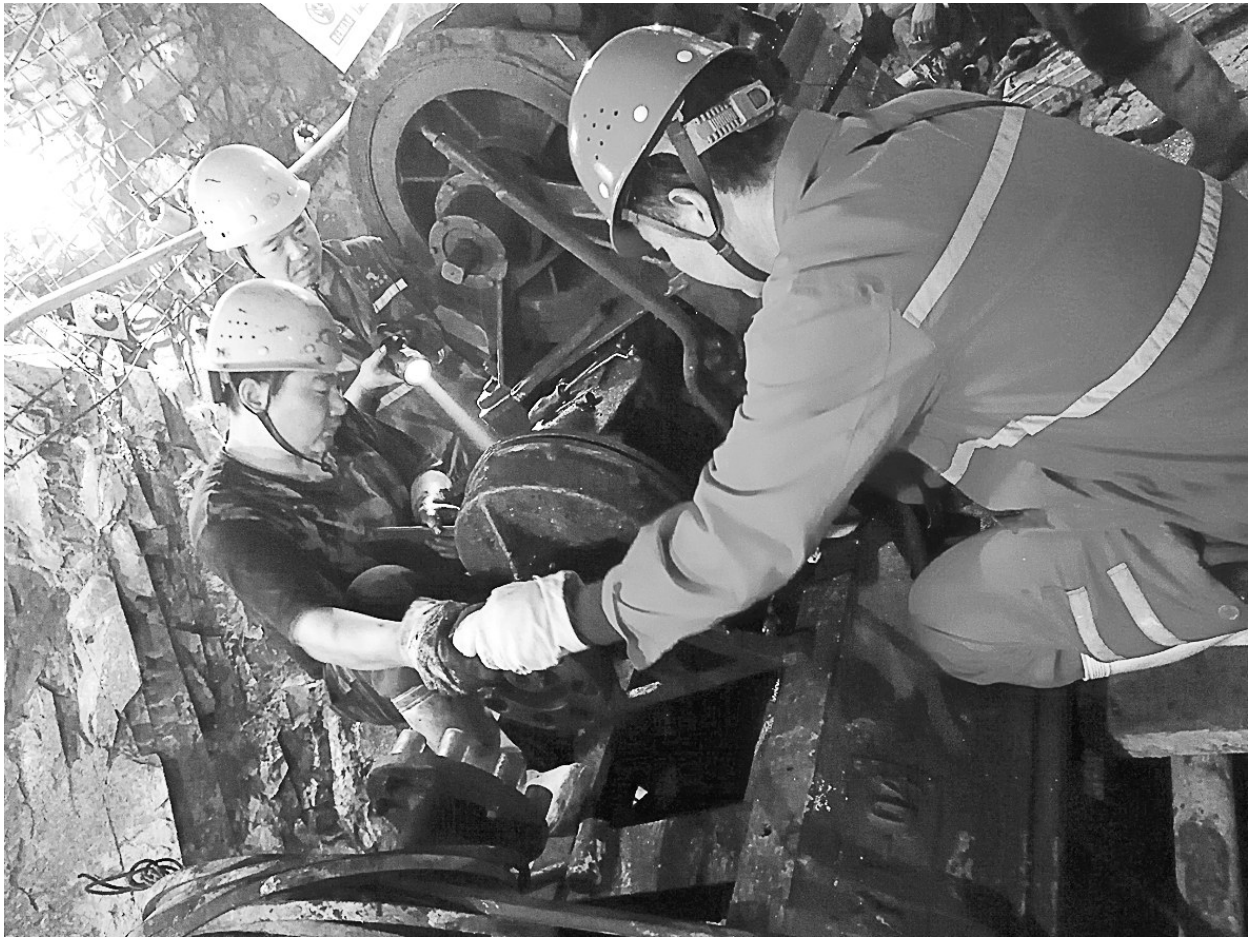
矿产资源中心第四项目部组织党员主力维修班组，利用班休非生产时间段开展设备检修和维护保养，提高纯钻时间，为完成生产任务提供强有力的保障。图为该班组正在进行设备检修。
