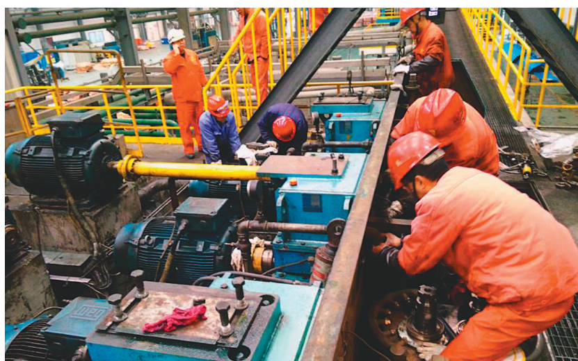
自去年12月20日起,工程技术分公司专业项目部承接铜冠铜材公司2018年度设备停产检修任务,项目包括升降梯、收线机、50台套电机大修、8台轧机减速机、11台冷却塔填料机更换及高压电气试验等。目前,检修项目全部完成。图为维修技术人员进行设备调试试车场景。陶星星 付家坤 摄
