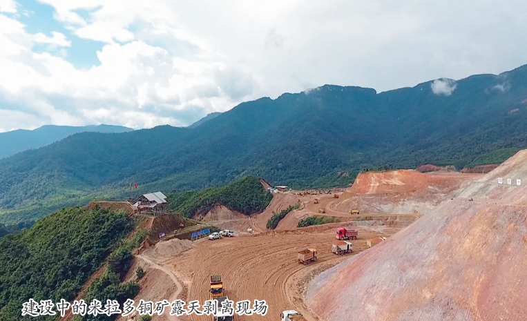
建设中铜阜康多个矿体的施工现场
