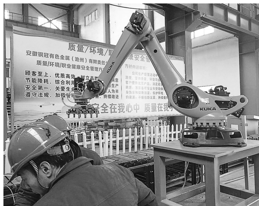
铜冠有色池州公司锌合金项目投入机器人刮皮与机器人码垛生产线各1套,目前机械手已安装到位,相关设备正在紧张安装调试中。自动线建成运行后压铸合金生产效率、产品物理外观质量、设备稳定性、人员配置等多方面指标将得到大幅度提高和优化。
