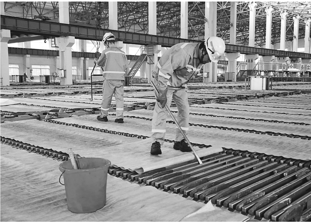
金冠铜业分公司奥炉厂区电解车间职工日前正在调整阴阳极板间距。奥炉厂区电解车间抢抓装出槽作业间隙,组织人员对电解槽面部分进液支管进行了适量抬高改造,确保了改造后的隔膜阀不再出现渗漏现象,从而保证了电解生产系统稳定。 王红平 封保敏 摄
