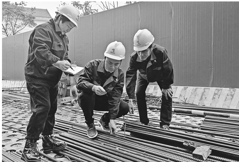
铜冠建安装饰公司日前提前组织项目现场材料盘点。今年以来,该公司不断强化管理机制、深化精细管理工作,通过严控劳务和材料支出,有效降低人工费和材料费,加强预算管理和强化现场管理降低施工成本,为全面完成2018年度各项考核指标奠定了坚实的基础。
