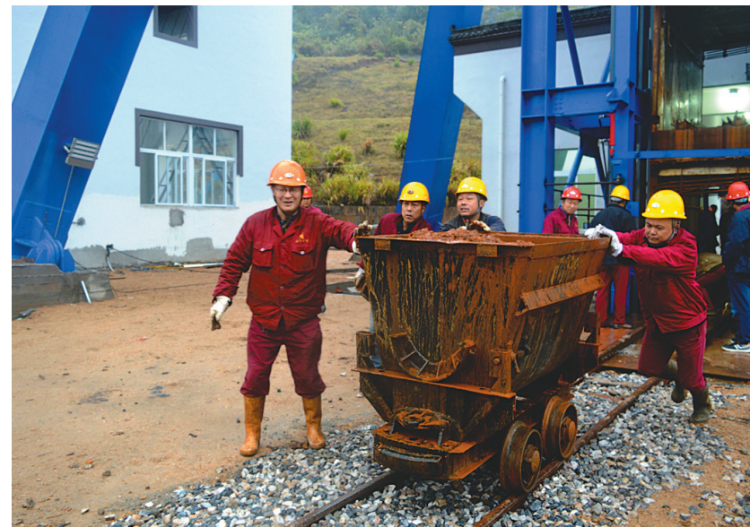
11月18日10时10分,满载着废石的第一辆矿车从天马山矿业公司副井井口顺利升井,标志着这个公司负395中段马头门延伸掘砌正式启动,为实现矿山深部开拓和后续资源接替奠定了坚实的基础。
