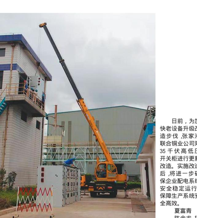
日前，为加快老设备升级改造步伐，张家港联合铜业公司对35千伏高低压开关柜进行更新改造。实施改造后，将进一步确保企业配电系统安全稳定运行，保障生产系统安全高效。
