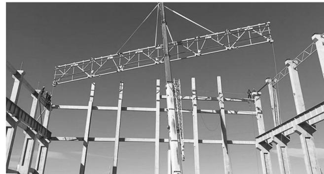
10月27日,铜冠建安钢构公司施工的金剑铜业冶炼升级搬迁改造项目电炉车间进入主体吊装阶段,开始厂房钢屋架的吊装。该工程建筑主跨面积约13500平方米。该公司第一批施工人员在10月16日抵达现场后,便迅速展开现场安装工作,实施职工吊装与钢屋架拼装同步进行,保障了工程施工有序有序推进。图为第一榀钢屋架吊装现场。 陈 潇 谢玉玲 摄
