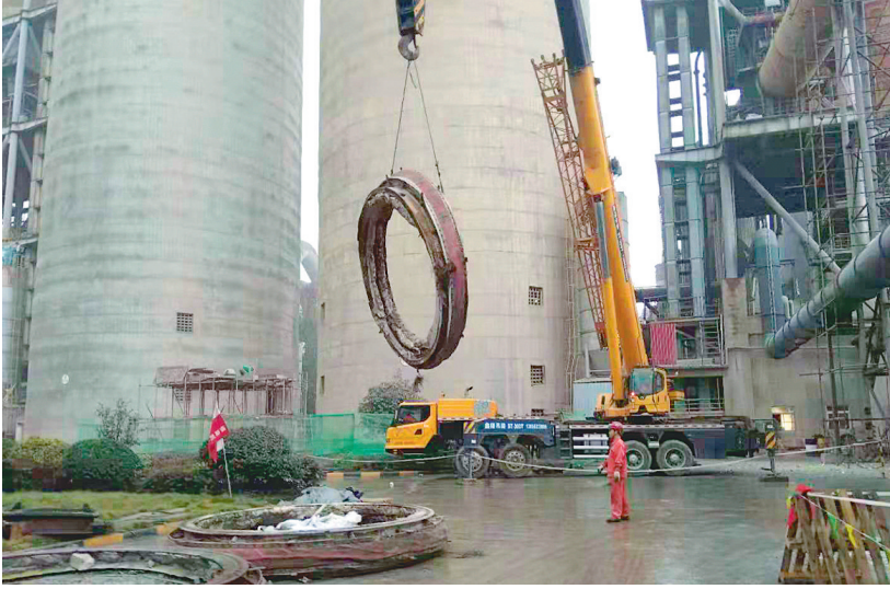
近日,工程技术分公司组织技术人员赴芜湖海螺进行3号生产线热风管道补偿器更换项目施工,这个项目为工程技术分公司首次涉足水泥行业,为积累跨行业维修经验奠定基础。
