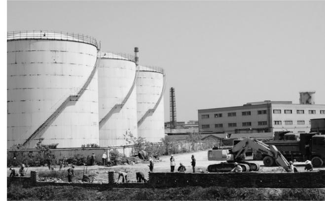
金隆铜业公司加大对重点设施及要害风险场所的安全管理防范工作,日前,该公司对存储硫酸的酸罐附近领域实行封闭式管理,强化安全措施,确保安全生产。图为相关人员正在酸罐周围砌筑遮挡围墙。
