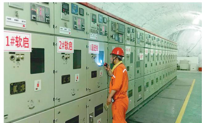
近日,铜冠(庐江)矿业公司为确保井下整个供电系统的正常运行,加大对矿井各处电力设施的巡检力度。图为巡检人员对井下中央配电所电气设备进行检查维护。
