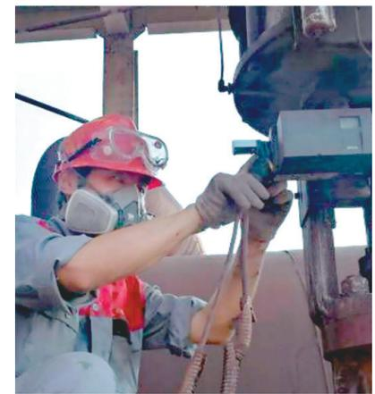
为避免业主单位培烧段DCS控制室发生雷击跳电和设备损坏情况,工程技术分公司循环园项目部表班经过多次技术交流,在铜冠冶金分公司专业管理人员的密切配合下,通过加装浪涌防雷设施(如图),确保生产控制系统正常运行。
