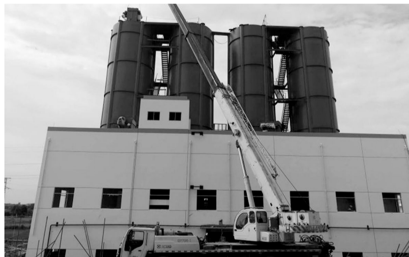
8月27日上午,随着铜冠(庐江)矿业公司充填站顶层电除尘装置安装到位,该充填站主体结构施工圆满完成,历时6个月的施工取得了阶段性胜利。 徐敏 李庆芳 摄
