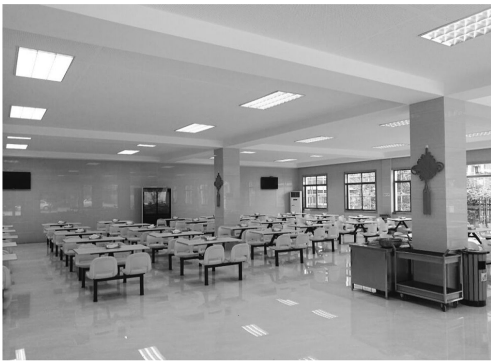
由铜冠建安装饰公司承担施工的集团公司机关餐厅日前已完工并投入使用。该工程建筑面积530平方米,铜冠建安装饰公司在承担项目后严格把控施工质量,按照节点进度组织施工,经过60天的奋战,顺利完成了餐厅的主体结构、装饰工程和室外道路等施工,确保了按期投入使用,有效改善了集团公司机关职工的就餐环境。 王红平 汪锡铜 摄
