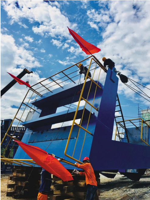
铜冠矿建公司职工顶着炎炎烈日吊装矿业井架。 曾红林 摄
