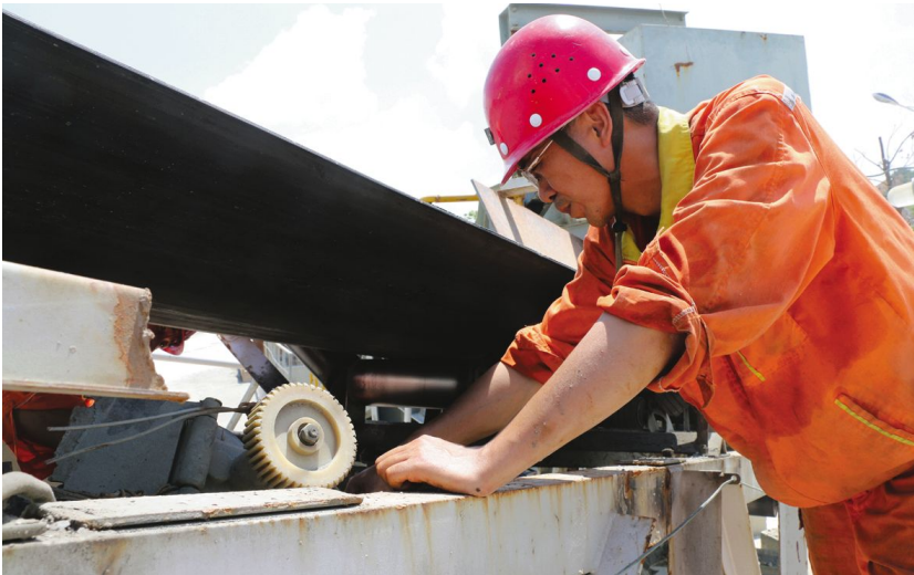
铜冠(庐江)矿业公司维修人员在高温下在对运输皮带进行修补。 王树辰 摄
