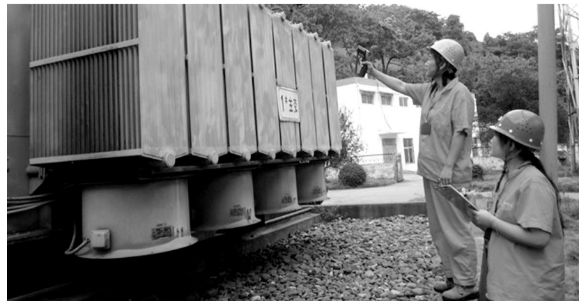
面对持续的高温天气,冬瓜山铜矿对110千伏变电所、压风机房等重点场所易产生高温的设备,增加巡检频率和维护力度,杜绝设备带病运行,确保矿山供电、供风两系统正常运行,安全度夏。 图为该矿动力车间配电工正在对主变110千伏桩头进行测温。 陶信宁 摄
