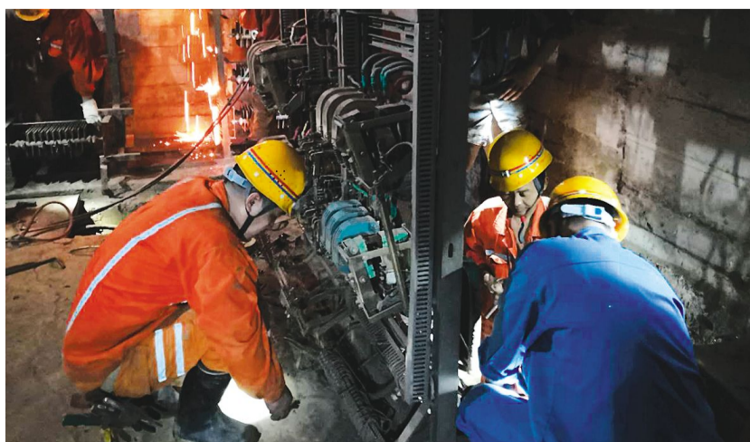
日前,凤凰山矿业公司机运车间完成了副井负360米粉矿回收并提升电控系统的改造工程,比原计划提前了2天完成了新设备的安装与调试,并一次性试车成功。图为改造现场。 黄志皓 摄
