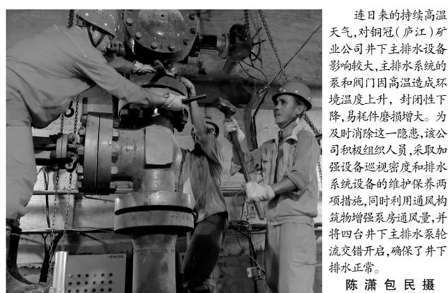
连日来的持续高温天气,对铜冠(庐江)矿业公司井下主排水设备影响较大,主排水系统的泵和阀门因高温造成环境温度上升,封闭性下降,易耗件磨损增大。为及时消除这一隐患,该公司积极组织人员,采取加强设备巡检密度和排水系统设备的维护保养两项措施,同时利用通风构筑物增强泵房通风量,并将四台井下主排水泵轮流交错开启,确保了井下排水正常。陈潇包 摄
