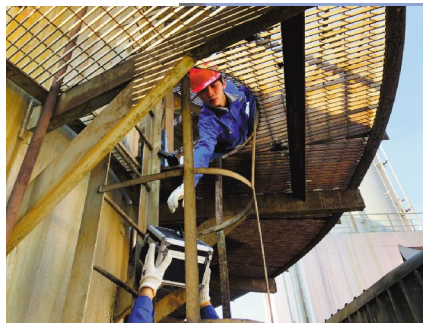
市环境监测中心站监测人员在锅炉脱硫塔烟囱上,对排污口点位进行监测。
