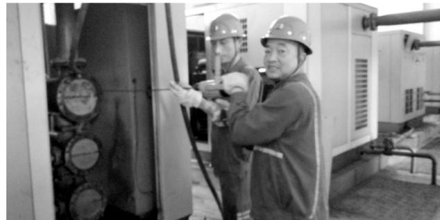
铜山铜矿分公司运转区坚持创新解难题,自制维修工具,确保井下供风系统畅通。图为该区组织精干力量,对使用的4号单螺杆式空气压缩机循环水系统疏通保养。
