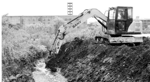
金隆铜业公司加强企业内部水排放口的管理,近日,该公司为提高稀贵金属总排放口的综合能力,防止其它外来水源进入本单位排放口,启动了排放水道的清淤疏浚工程,确保河道水流畅通,免受外来水体环境影响。图为挖掘机正在疏浚排放口下游水道。
