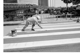
金隆铜业公 司在抓好安全生 产工作中,注重各 种安全标识的运 用,以达到对职工 进行提示警醒的 作用,从而做到安 全警钟长鸣。该公 司在厂区各条道 路上标画行人斑 马线,实施行人优 先原则,避免人车 抢道,消除安全隐
