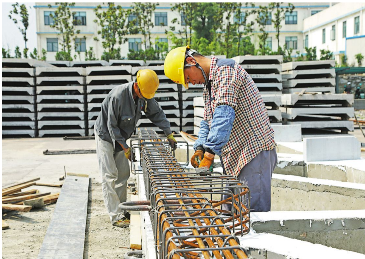
日前,铜冠建安新型环保建材公司职工正在绑扎预制构件钢筋。铜冠建材公司今年在积极做好混凝土砌块、蒸压标准砖、铺地砖、预拌干混砂浆和特种砂浆等新材料生产销售的同时,加大了传统预制构件的制作业务,并于近期成功地承接了六国化工皮带廊预制构件的制作订单。为确保工期,该公司组织职工在生产基地加快制作。 王红平 高明摄
