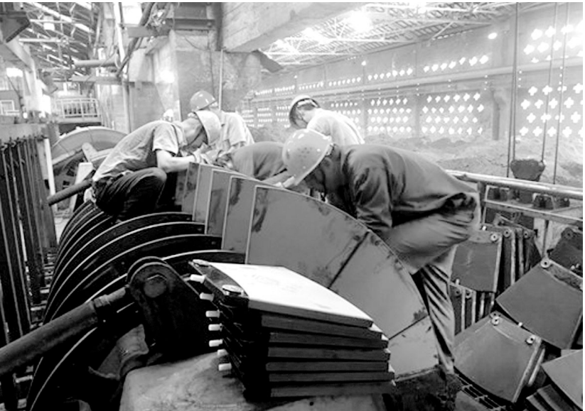
日前，天马山黄金矿业公司利用矿源不足短暂停产期间，全方位加强设备系统维护与保养，组织精兵强将对精矿大班陶瓷板进行拆除、更换与安装，确保各项指标稳定。图为陶瓷过滤器拆除现场。
